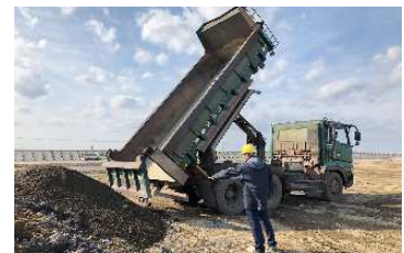
積荷展開検査の様子
