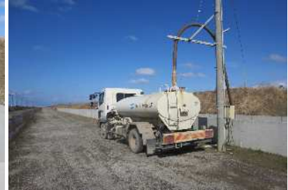
雨水を散水車に給水している様子
