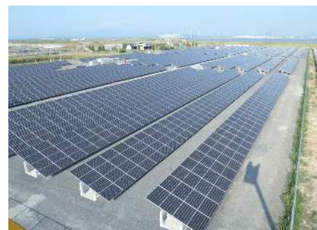
ひびきソーラーパワーの外観
