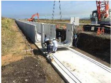
外周水路設置工事の様子
