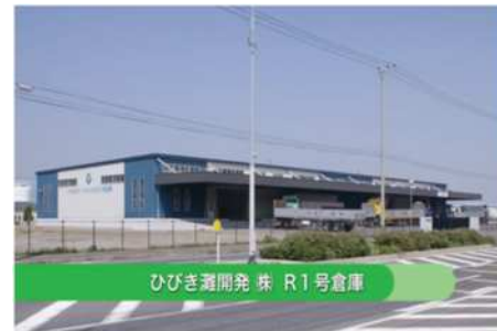
R・1号倉庫の外観
