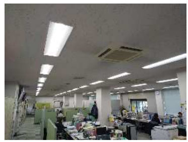
LED照明に取替え後
