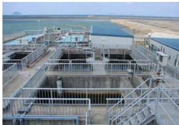
排水処理施設の外観
