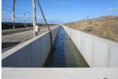
完成後の外周水路(給水ポンプ設置)
