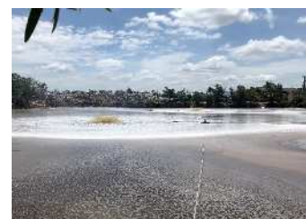
エアレータ導入の様子
