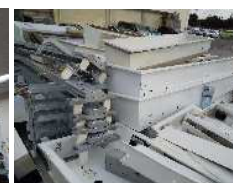
取替え作業中
