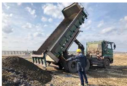
展開検査の様子
