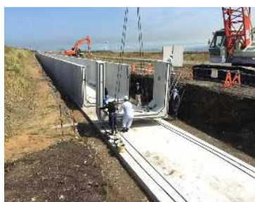
外周水路設置工事の様子
