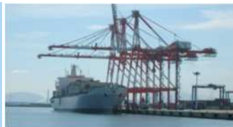
ひびきコンテナターミナル
