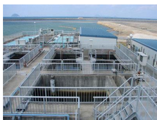
排水処理施設の外観
