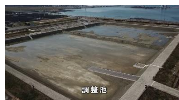
調整池の外観
