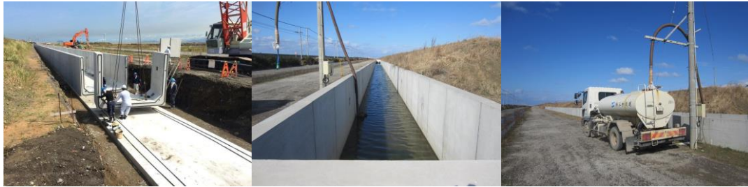
外周水路設置工事の様子
