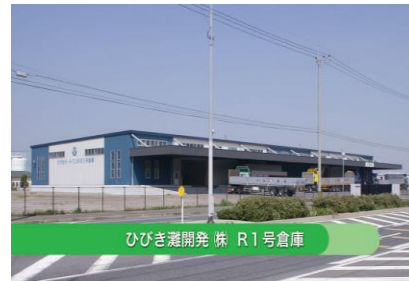
R1号倉庫の外観
