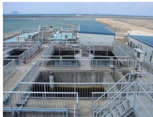
排水処理施設の外観
