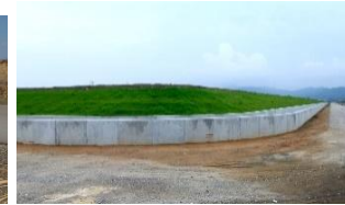
嵩上土堰堤の緑化
