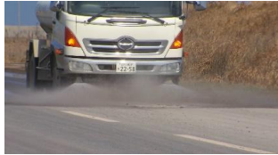
散水作業の様子
