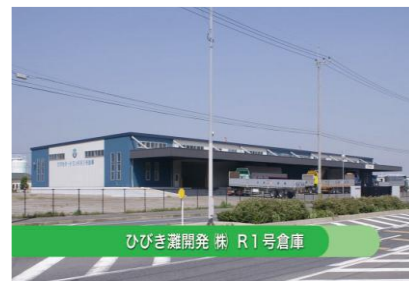
R1号倉庫の外観
