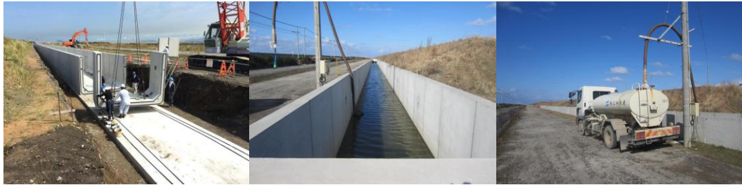
外周水路設置工事の様子
