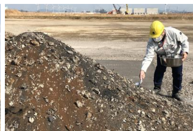
抜取検査の様子
