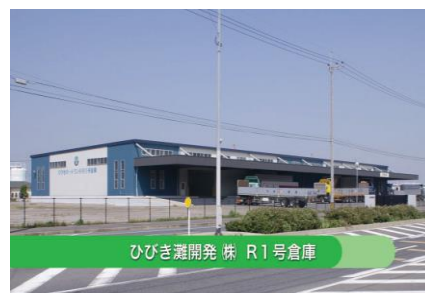
R・1号倉庫の外観
