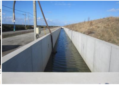
完成後の外周水路(給水ポンプ設置)
