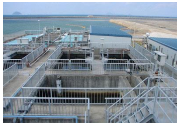
排水処理施設の外観
