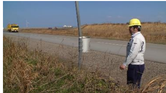
降下ばいじん量の監視
