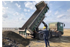
積荷展開検査の様子
