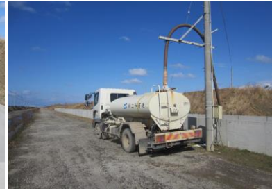
雨水を散水車に給水している様子
