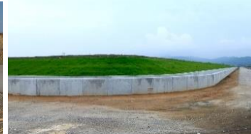
嵩上土堰堤の緑化
