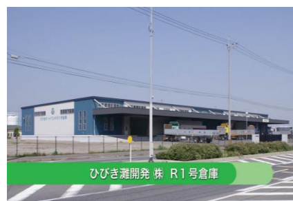
R・1号倉庫の外観
